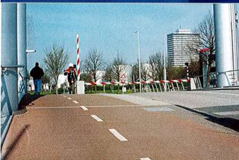
PAKOR-Slijtlaag TV (Fietspaden en stalen hefbrug)
