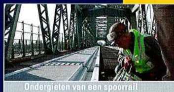
Ondergieten van een spoorraai
