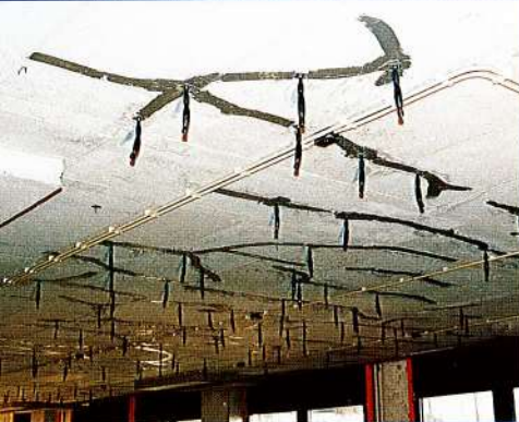
Injectie met BICS (plafond)
