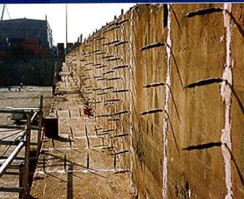
Injectie met BICS (wand)
