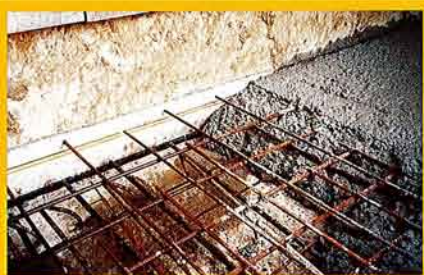
Montage van INFILTRA-STOP bij het storten van een vloer tussen bestaande wanden (bv. betonwand, damplanken-wand, etc.)
