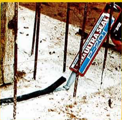
P-201 is bij uitstek geschikt voor het verlijmen van ADEKA ULTRA SEAL op ruwe ondergronden en voor het maken van onderlinge verbindingen van afzonderlijke profielen
