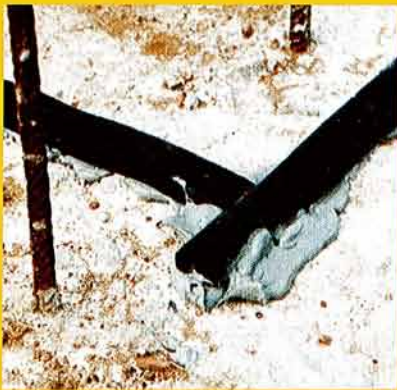
P-201 is bij uitstek geschikt voor het verlijmen van ADEKA ULTRA SEAL op ruwe ondergronden en voor het maken van onderlinge verbindingen van afzonderlijke profielen
